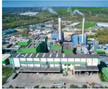
Abfallkraftwerk RZR Herten © AGR
