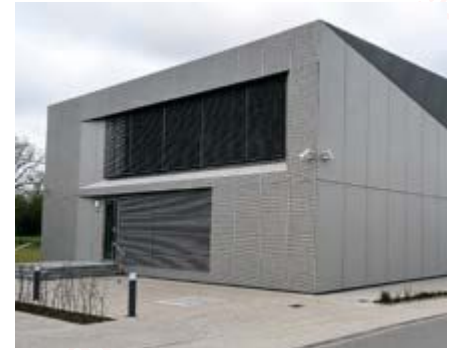
RAG-Leitwarte © Dirk Langer
